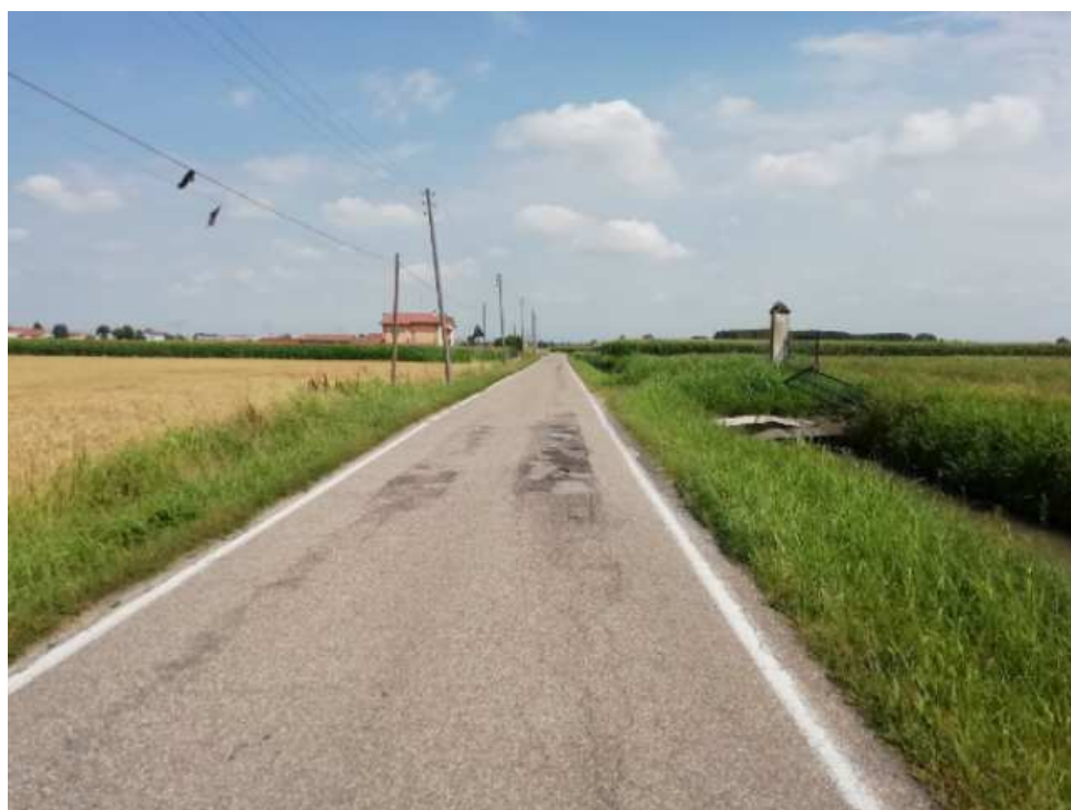
Foto 12 – via Campaiaro (E2)
